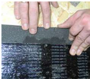
Рис. 85. Насечка для облегчения монтажа
