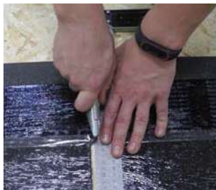
Рис. 86. Деление плитки на лепестки
