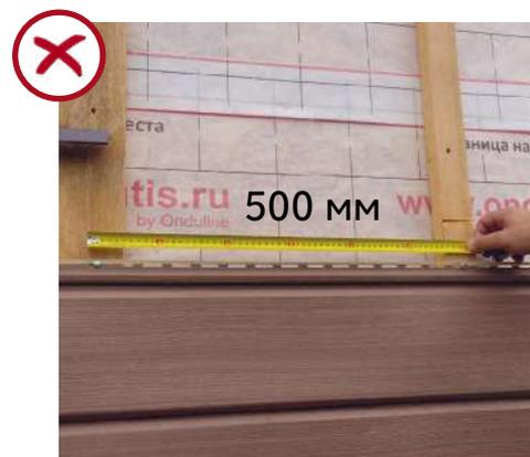
**2.2** Обрешетка находится в одной плоскости (натяните шнурку от угла до угла в плоскости стены. Обрешетка не должна доходить до шнурки 1 мм):
