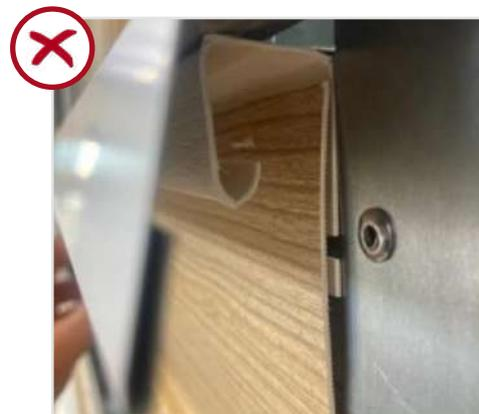
**4.3** Под завершение стены подрезанная панель сайдинга фиксируется с использованием насечек в финишной планке, смонтированной совместно с угловым элементом:
