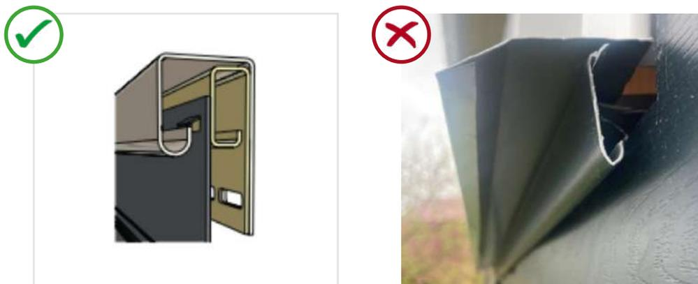
**3.6** На оконных и дверных проемах околооконная планка зафиксирована в финишной планке с помощью насечек:
